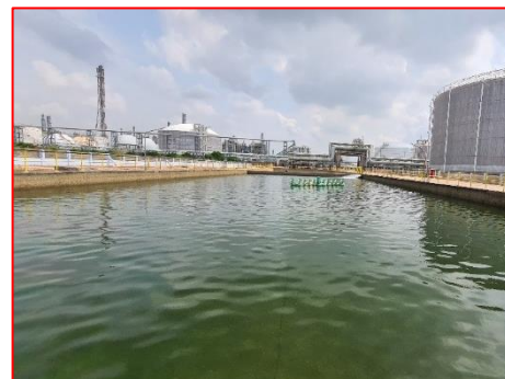
ภาพที่ 2.2-4 บ่อรองรับน้ำทิ้งจากระบบบำบัด น้ำเสียส่วนกลาง (Receiving Pond)
