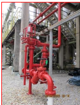
ระบบท่อน้ำดับเพลิง
